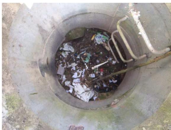
*Radier dégradé – Regard n°2017 – Réseau pluvial*
