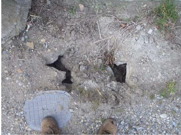
*Orifice dans la conduite – Réseau pluvial -
