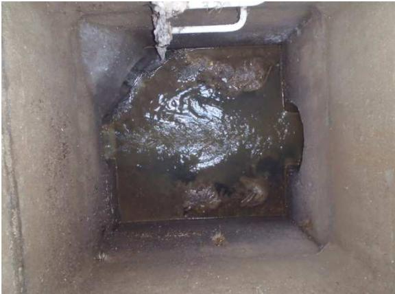
*Absence de cunette / dépôts / stagnation d'effluent / traces de mise en charge – Regard n°395 – Réseau eaux usées – Avenue du Rhône*
