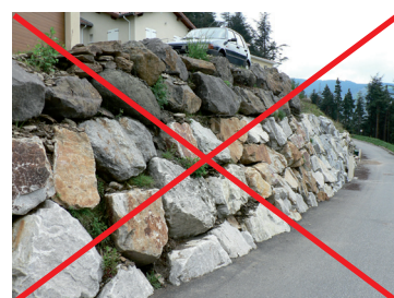
Exemple d'enrochements de type cyclopéen
