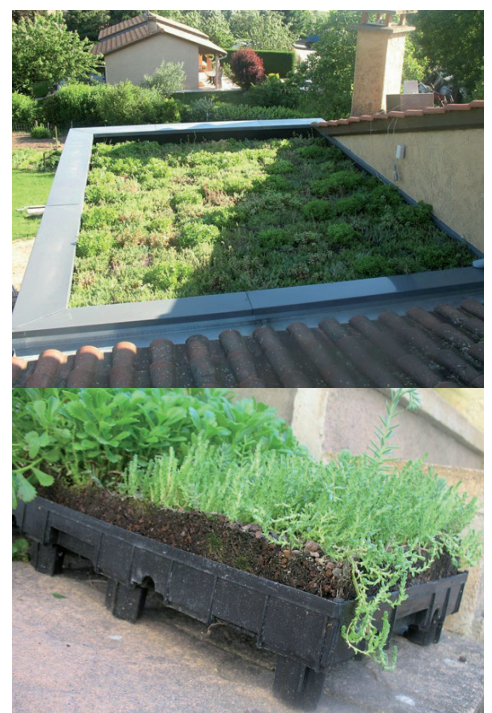
Exemple de toiture-terrasse végétalisée et bacs pré-cultivés
